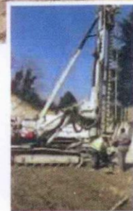
■ Le chantier est en phase de démarrage. En médaillon, la foreuse sonde le terrain avant les fondations. Photos Jocelyne Takali
